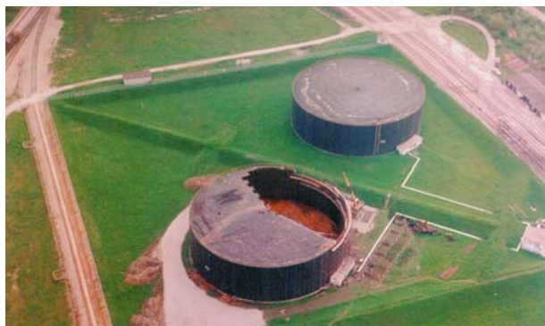
Slika 5. Pogled na R5 i R6
